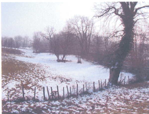
PHOTO 1 : Photo prise au droit de la digue du bassin de rétention, en rive gauche, vers l'aval
